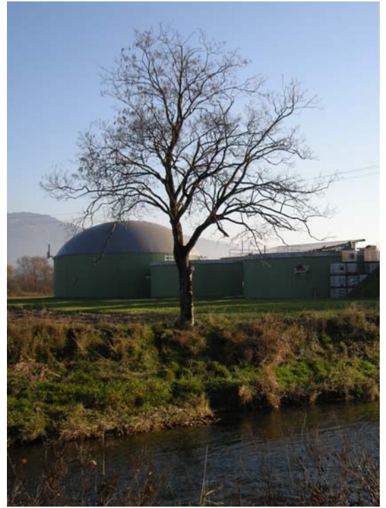
Anlage rhy biogas
