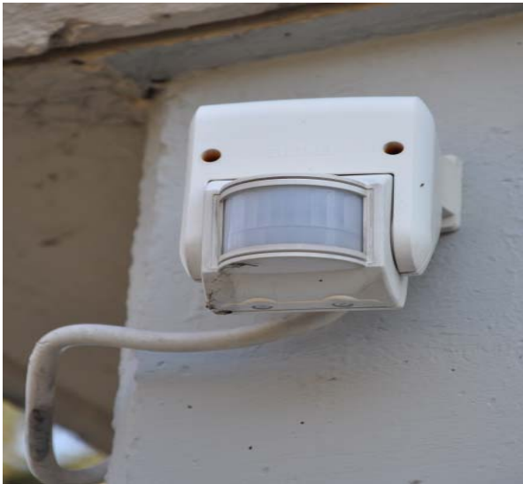
Bewegungsmelder reagieren meist auf Wärmestrahlen (Wellenlänge zirka 10 µm)
